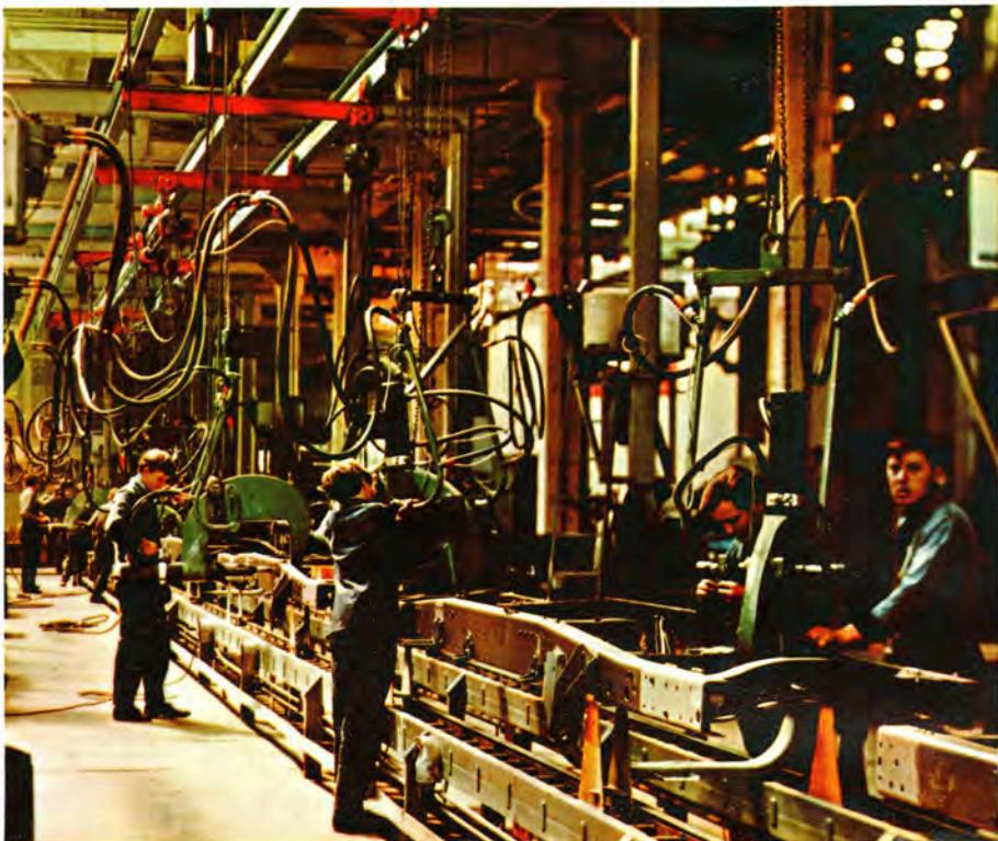
Rahmenmontageband der IFA W 50 Nutzkraft- wagen
